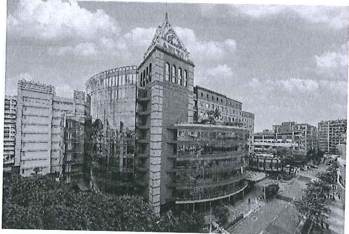
瑞光大樓II運用台達電Delta Controls enteliWEB建築中控系統，整合空調、照明、安防監控、再生能源及電動車充電等多項子系統，配合Delta Energy Online系統監控用電效率，管理需量控制。
