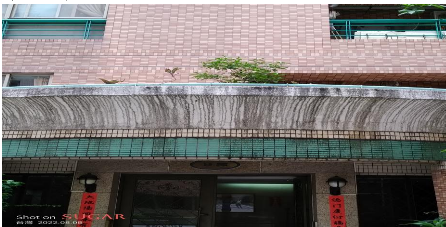
B, C棟-社區大門左右警衛室上方
